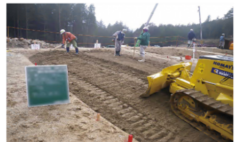
砂防ソイルセメント工法(施工：流動タイプ)
