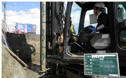
地盤補強工事
