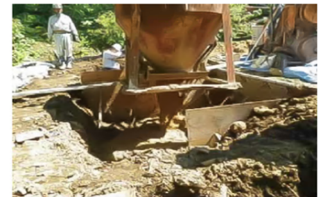
砂防ソイルセメント工法(施工：流動タイプ)
