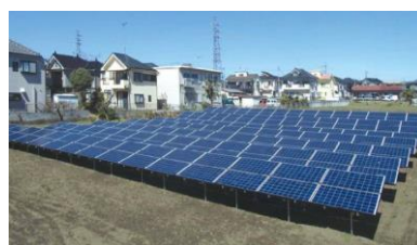
土地への設置
