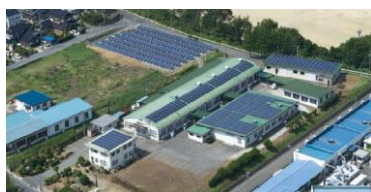
工場への設置
