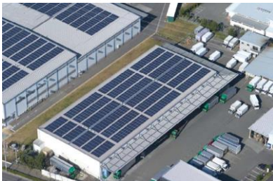
倉庫への設置
