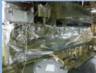
◀ アルミホイル施工の様子
